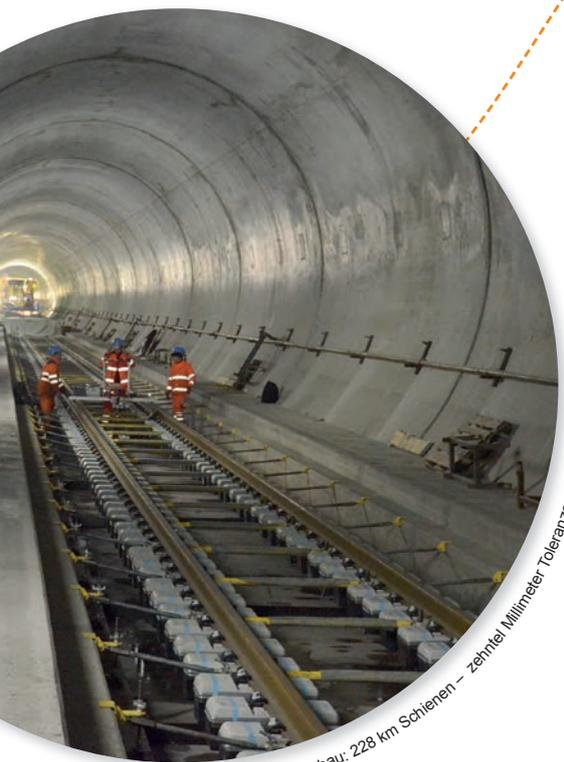
Präzision im Gleisbau: 228 km Schienen – zehnter Millimeter Toleranzen sind entscheidend.
