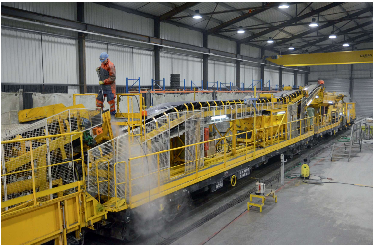
Die Wartung des Betonzugs nach 16 Stunden Einsatz; Foto: Transtec Gotthard
