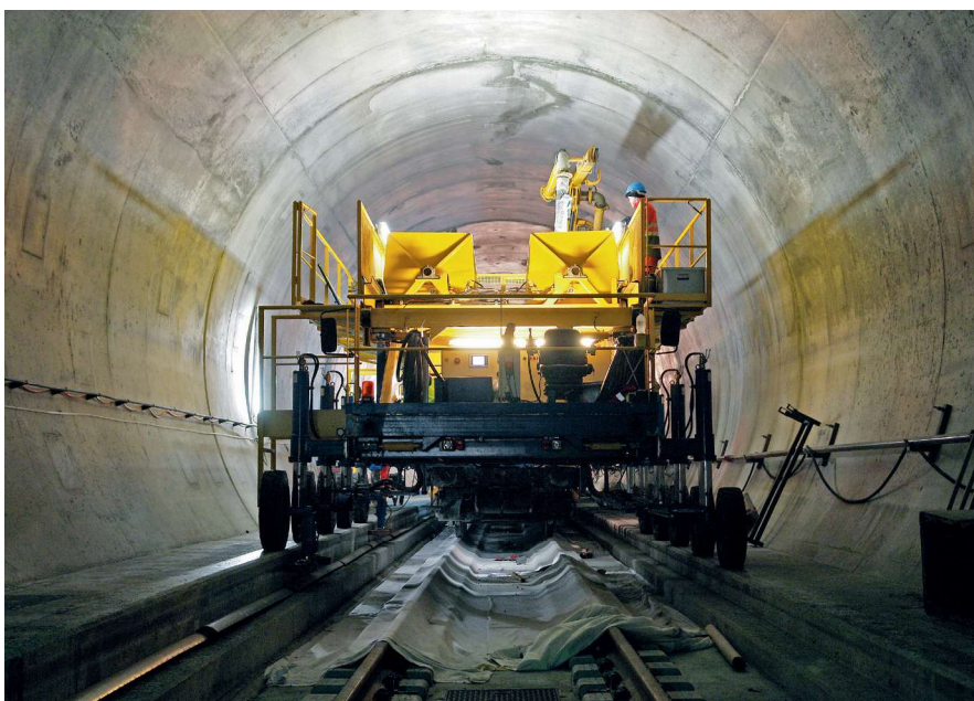
Der Betoneinbau: 16 Stunden am Tag war im Tunnel Baubetrieb. Foto: Alptransit Gotthard
