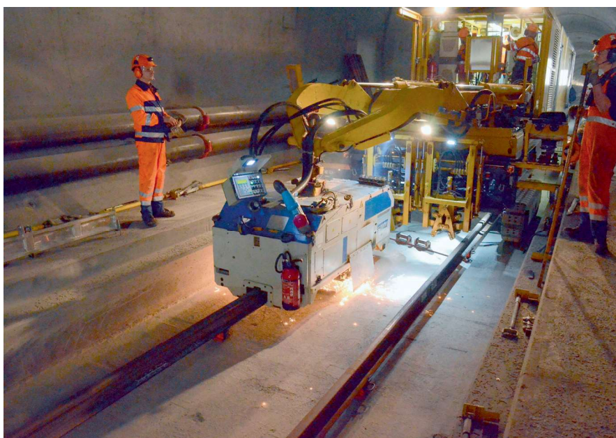
Hochpräzises Arbeiten beim Einbau der Schienen; Foto: Transtec Gotthard
