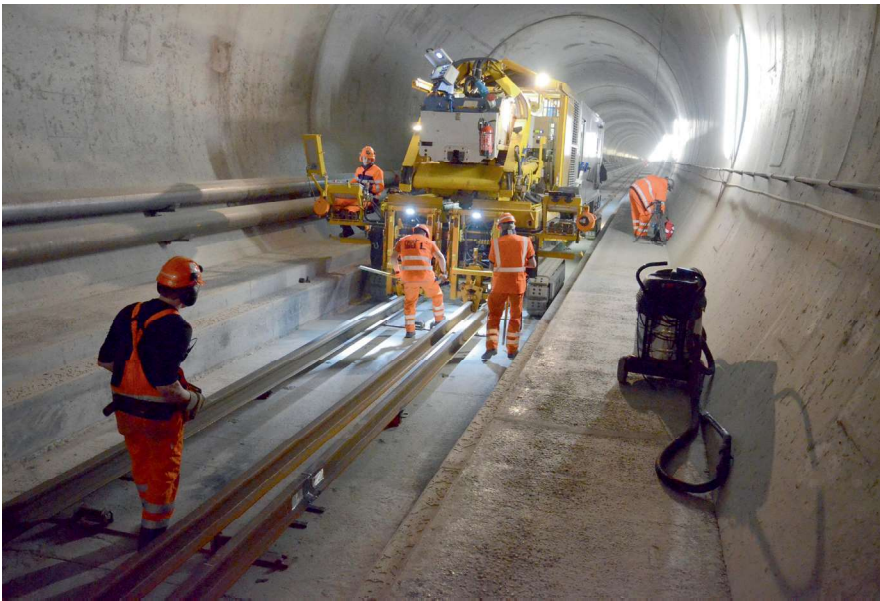
Die Toleranzen für die Hightech-Schienen liegen manchmal bei einem Millimeter.
